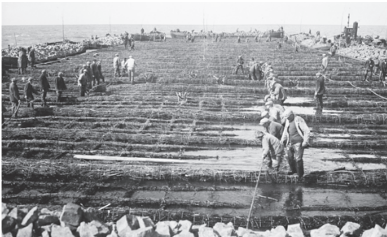
18 Een zinkstuk met stortstenen in de maak voor de Afsluitdijk. Foto: Historisch Archief van periode 1900-1960. Inv.nr. RWS_3558. Bron: https://beeldbank.rws.nl , Rijkswaterstaat / Afdeling Multimedia Rijkswaterstaat.
